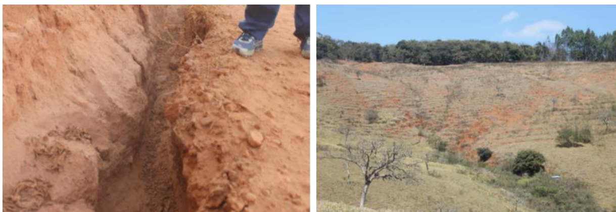
Estradas não pavimentadas
