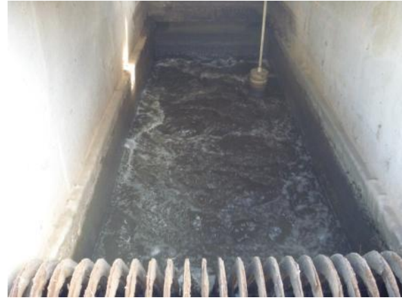
Figura 1.5 – Gradeamento do tratamento preliminar
