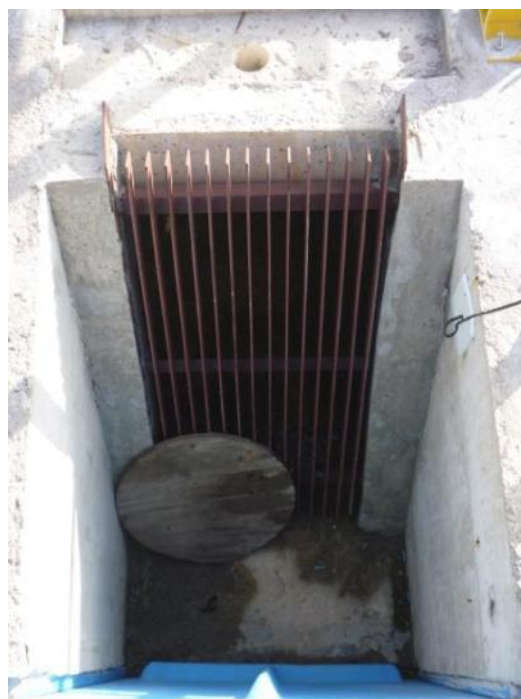
Figura 1.11 – Gradeamento
