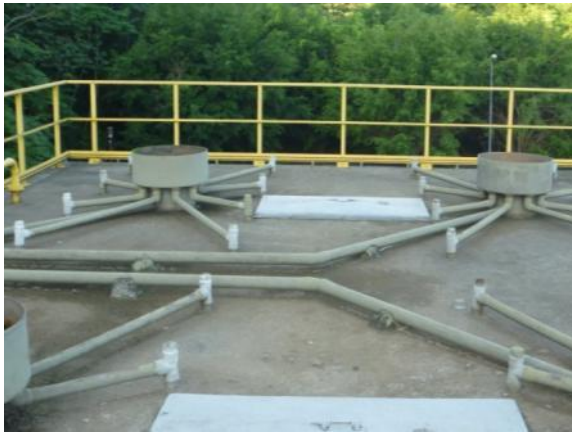
Figura 1.26 – Sistema de distribuição do reator UASB
