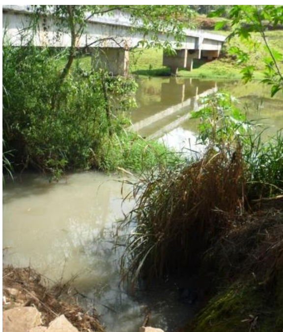
Figura 1.3 – Lançamento no rio Santa Bárbara, no bairro Centro (ponte Dr. Francisco)
