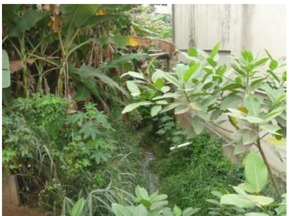
Figura 1.3 – Lançamento difuso de esgoto no córrego dos Fundos na área central
