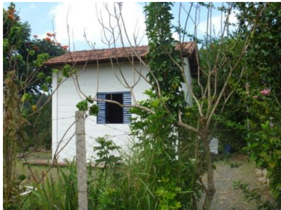
Figura 1.32 – Casa de apoio
