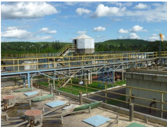
Figura 1.8 – Vista superior dos reatores UASB
