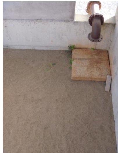
Figura 1.19 – Interior do leito de secagem de lodo
