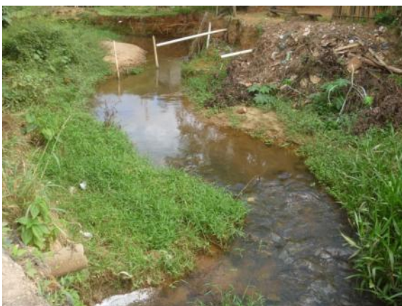
Figura 1.4 – Tubulações de esgoto no córrego Soveno, na área central
