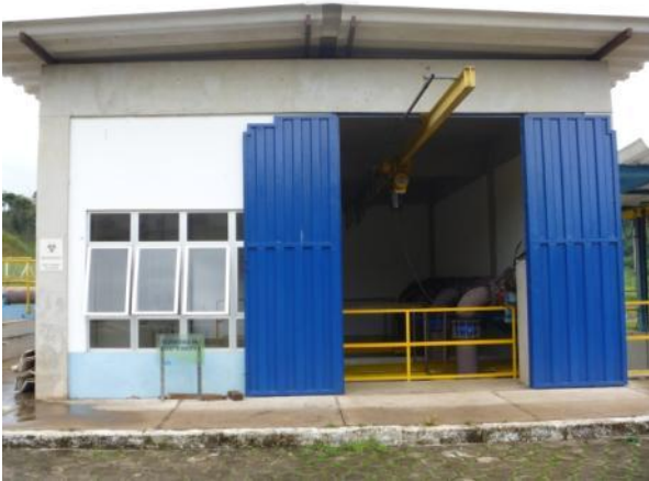
Figura 1.9 – Estação elevatória de esgoto bruto
