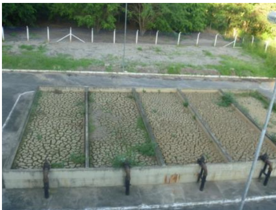
Figura 1.30 – Leitões de secagem
