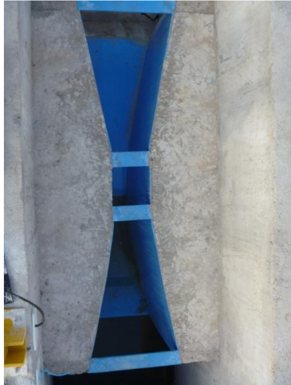
Figura 1.13 – Calha Parshall
