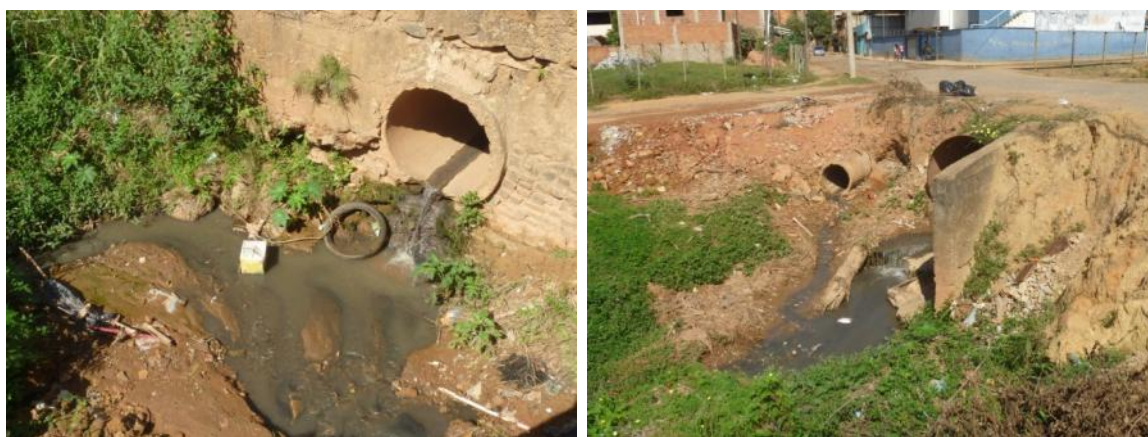
Figura 1.5 – Lançamento de esgoto no córrego do Industrial, no bairro Industrial Figura 1.5 – Lançamento de esgoto no córrego do Industrial, no bairro Industrial
