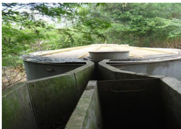
Figura 1.41 – Desarenador
