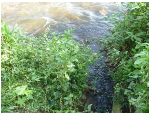
Figura 1.13 – Lançamento de esgoto in natura no córrego Santarém
