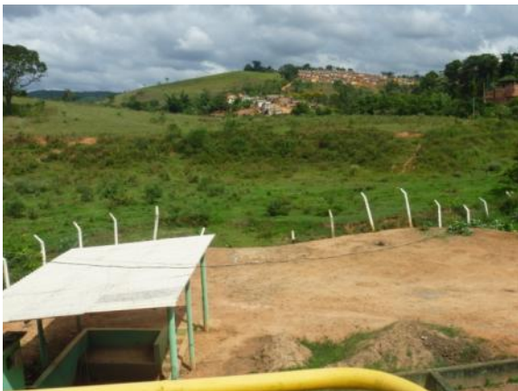
Figura 1.11 – Vista parcial da ETE e ao fundo conjunto habitacional COHAB
