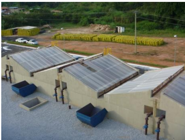
Figura 1.18 – Leitões de secagem de lodo
