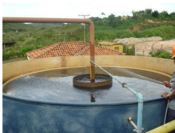
Figura 1.5 – Decantador (Uso de mangueiras para dispersar lodo)
