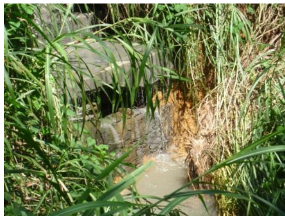
Figura 1.4 – Lançamento de esgoto em córrego desconhecido
