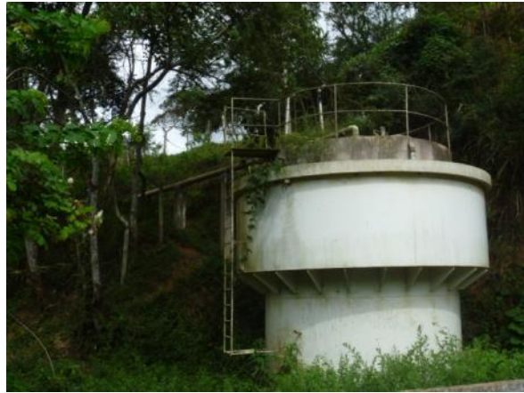
Figura 1.15 – Sistema Híbrido UASB/Filtro
