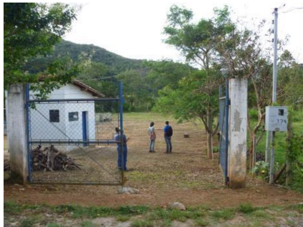
Figura 1.5 – Presença de cercamento e portão de acesso
