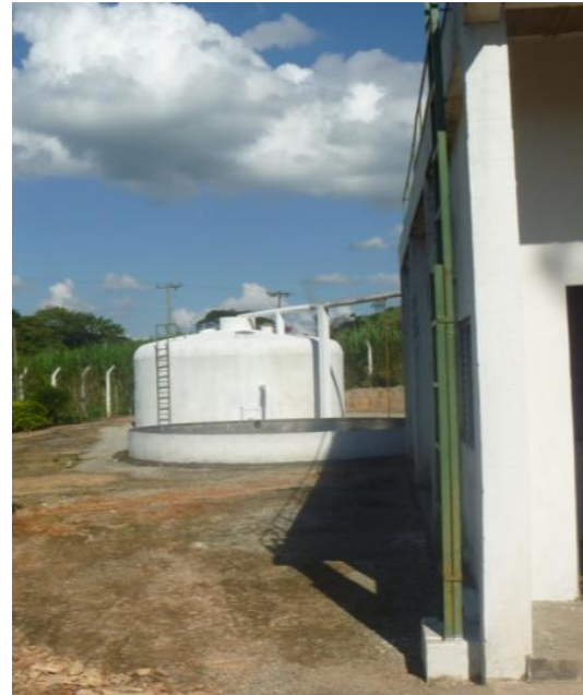
Figura 1.3 – Detalhe para as escadas de acesso ao tratamento preliminar e ao reator UASB
