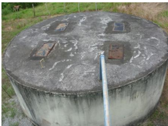
Figura 1.14 – Vista superior do Filtro Anaeróbio
