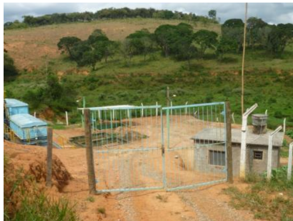
Figura 1.12 – Vista frontal da ETE
