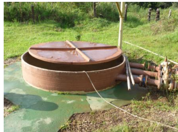
Figura 1.14 – Bombeamento ( Do tratamento preliminar para tanques)
