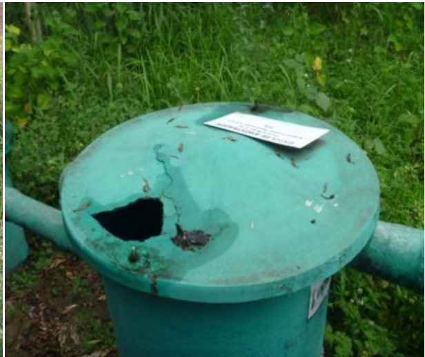
Figura 1.6 - ETE Severo/Caixa de amostragem comprometida (pré leitos de secagem)
