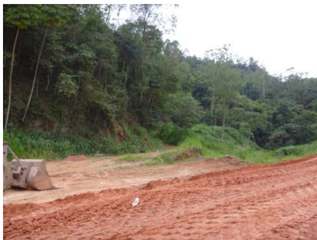
Figura 1.22 – Área destinada para implantação da ETE Carneirinhos
