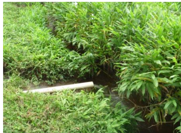
Figura 1.34 – Lançamento do efluente tratado
