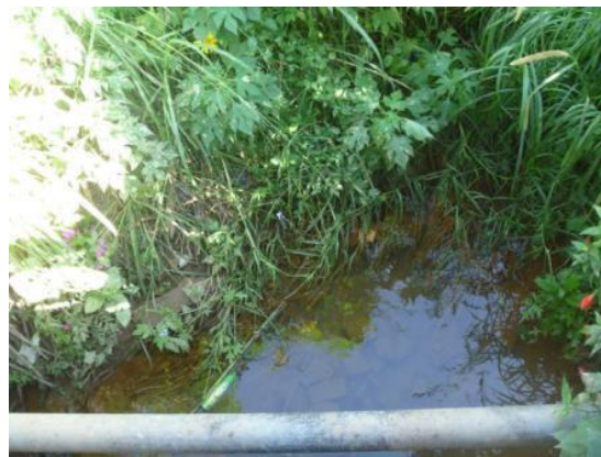
Figura 1.6 – Lançamento do esgoto in natura no córrego da Bahia, distrito de Conceição de Piracicaba
