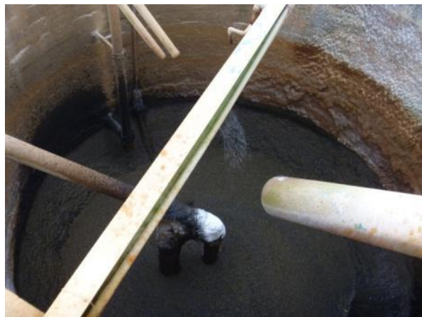
Figura 1.14 – Lodo disposto no tanque pulmão
