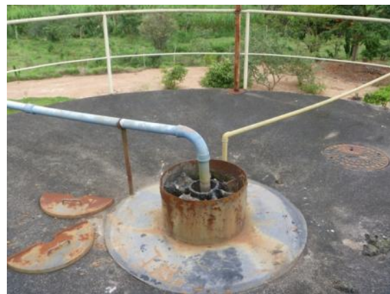
Figura 1.13 – Vista superior do Reator UASB
