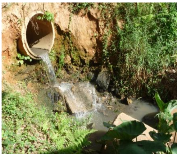
Figura 1.3 – Lançamento do esgoto in natura na sede, Rio do Peixe, afluente do Piranga
