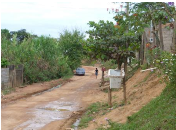
Figura 1.1 – Lançamento de esgoto a céu aberto
