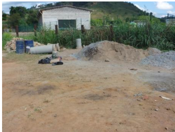
Figura 1.16 – Área da antiga ETE 3 – Baixada da Pimenta
