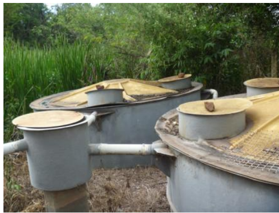
Figura 1.39 – Filtros Anaeróbios
