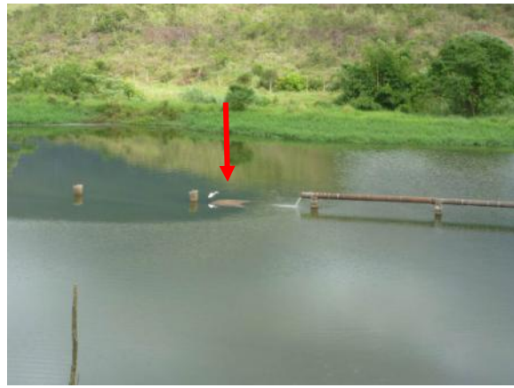
Figura 1.25 – Assoreamento na lagoa facultativa
