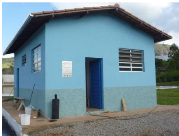
Figura 1.5 – Casa de apoio
