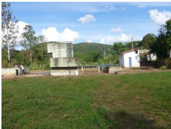
Figura 1.4 – Vista geral da ETE São Bartolomeu
