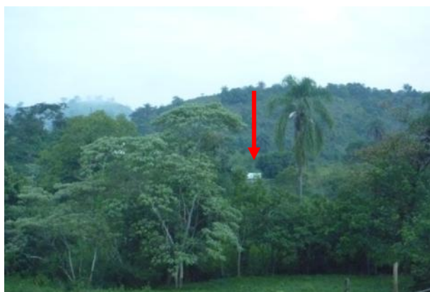
Figura 1.25 – Vista distante da ETE Ipoema
