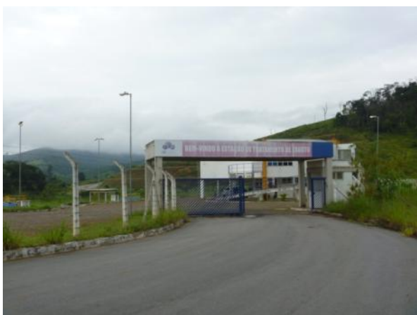
Figura 1.3 – Vista geral da ETE Laboreaux
