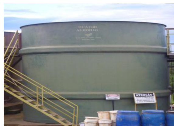
Figura 1.8 – Reator Aeróbio
