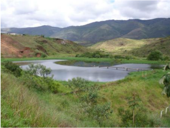
Figura 1.24 – Vista geral da ETE Samarco
