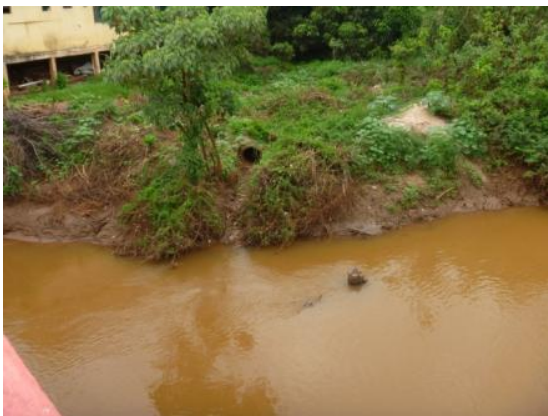
Figura 1.5 – Lançamento do esgoto bruto no rio Piracicaba / Centro da cidade
