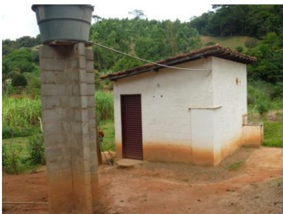
Figura 1.16 – Casa de apoio
