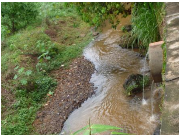
Figura 1.3 – Lançamento de esgoto na rede pluvial no córrego Viúva
