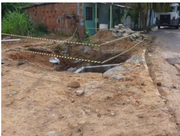
Figura 1.17 – Obras de drenagem pluvial
