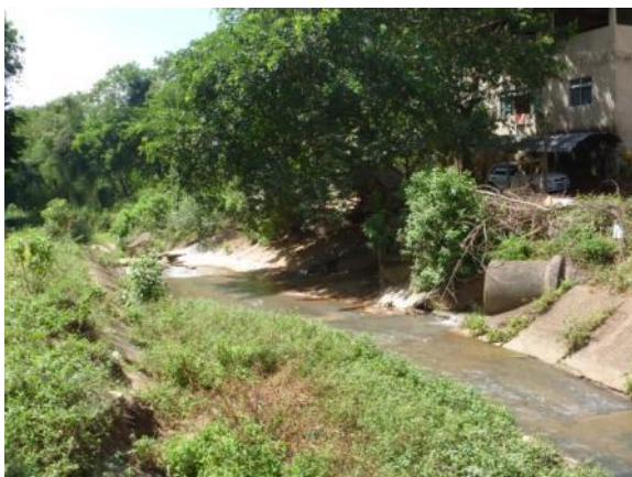
Figura 1.3 – Lançamento de esgoto na rede pluvial na confluência dos córregos Sebastião Cota e Lindolfo
