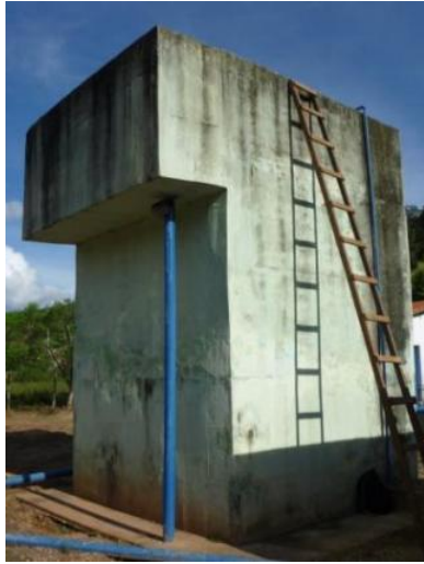
Figura 1.8 – Escada do reator UASB
