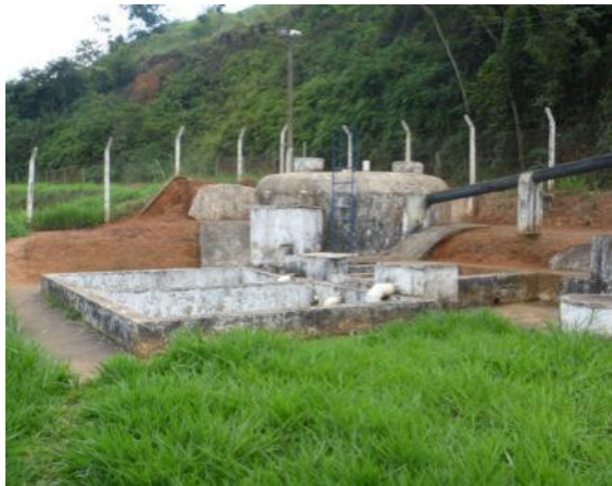
Figura 1.8 – Filtro anaeróbio
