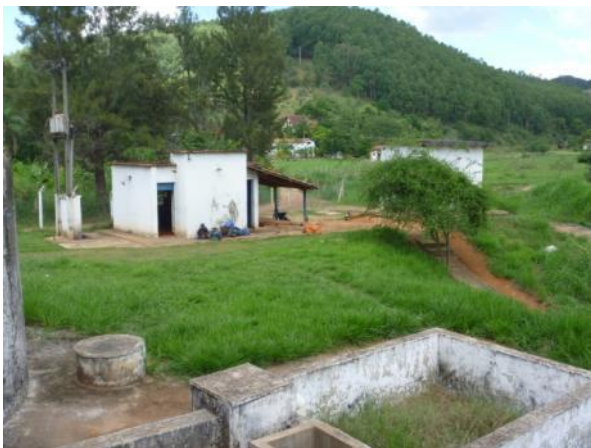
Figura 1.10 – Estruturas de captação e bombeamento de água
