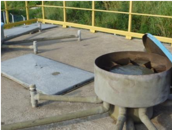
Figura 1.15 – Sistema de distribuição do reator UASB
