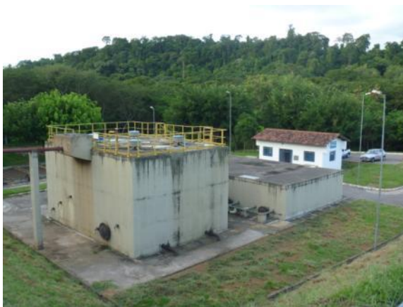
Figura 1.35 – Vista superior da ETE
