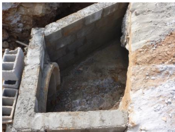
Figura 1.18 – Obras de drenagem pluvial
