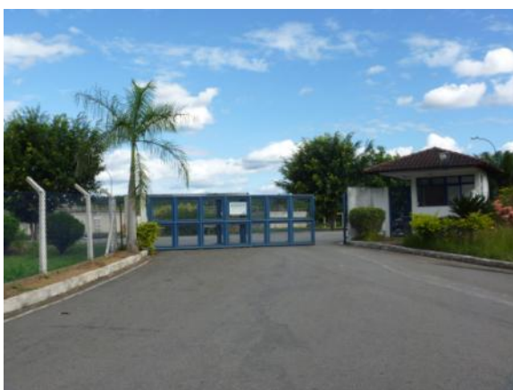
Figura 1.2 – Entrada da ETE
