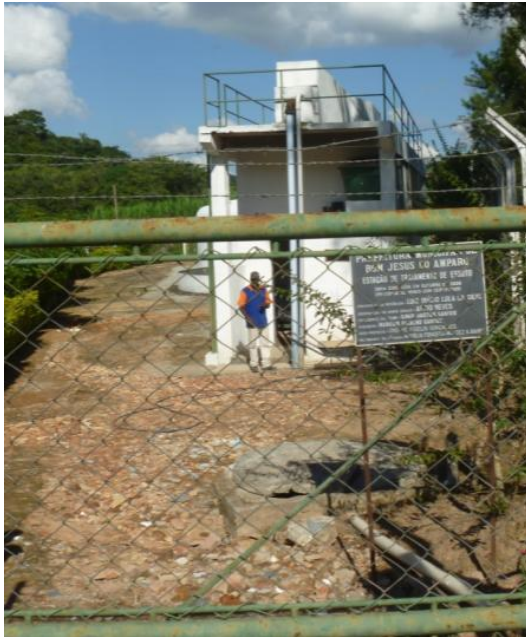
Figura 1.2 – Vista frontal da ETE
