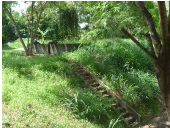
Figura 1.12 – Área da ETE coberta por vegetação
