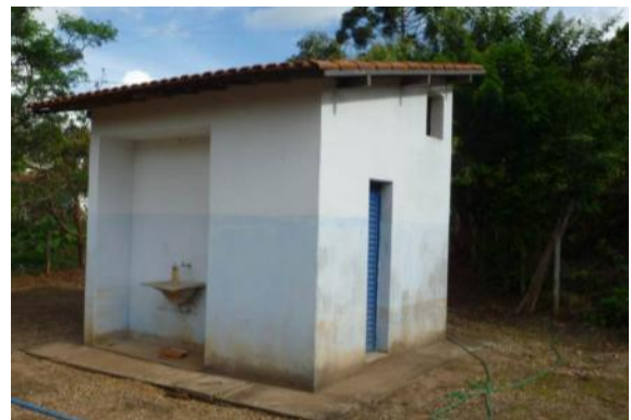
Figura 1.13 – Casa de apoio
