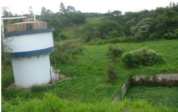
Figura 1.33 – Vista parcial da ETE
