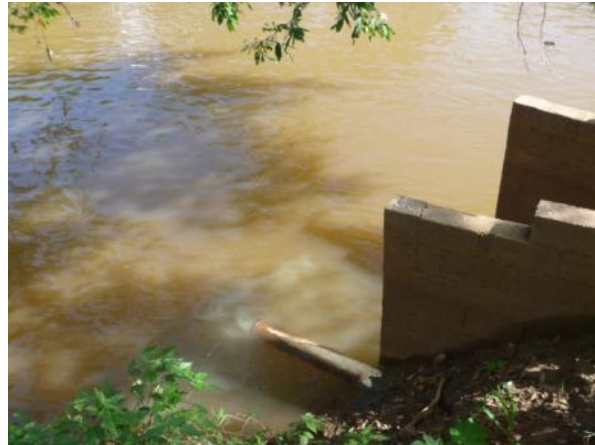
Figura 1.2 – Lançamento de esgoto bruto no rio Piracicaba
