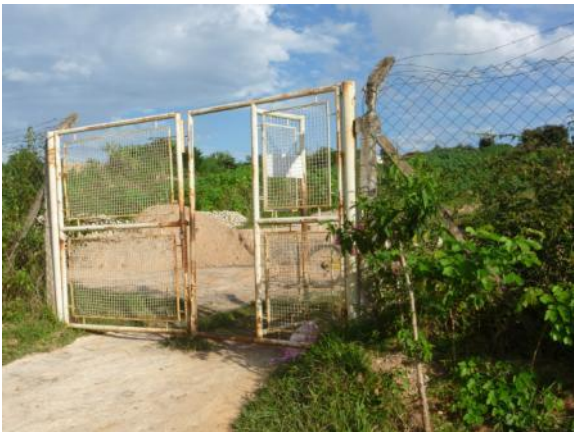
Figura 1.11 – Entrada da ETE
