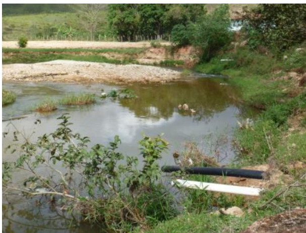
Figura 1.11 – Lançamento de esgoto bruto no ribeirão Águas Claras
