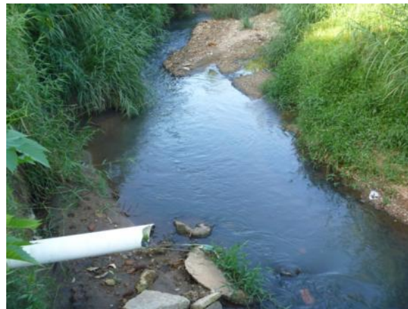
Figura 1.2 – Lançamento de esgoto bruto no córrego Jacuí
