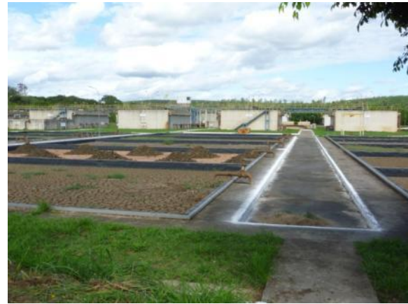
Figura 1.7 – Vista geral dos reatores UASB e leitos de secagem
