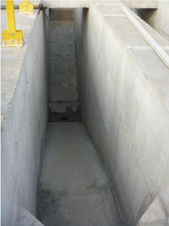
Figura 1.12 – Desarenador
