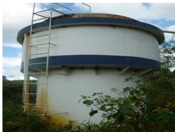
Figura 1.26 – Sistema Híbrido UASB/Filtro
