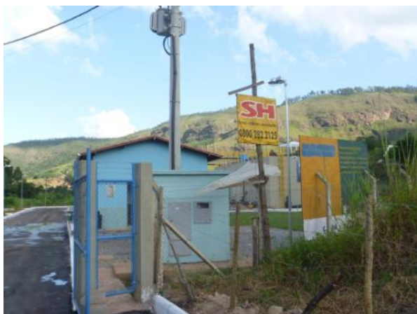
Figura 1.4 – Entrada de acesso à ETE
