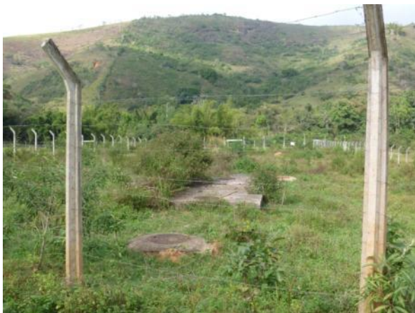
Figura 1.19 – Visa geral da ETE Furquim
