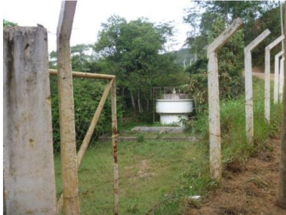
Figura 1.20 – Vista externa da ETE
