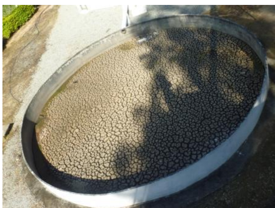
Figura 1.8 – Leito de secagem
