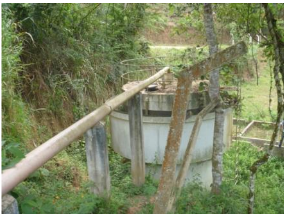
Figura 1.18 – Vista superior da ETE
