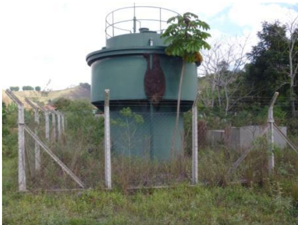
Figura 1.25 – Reator UASB conjugado a filtro anaeróbio
