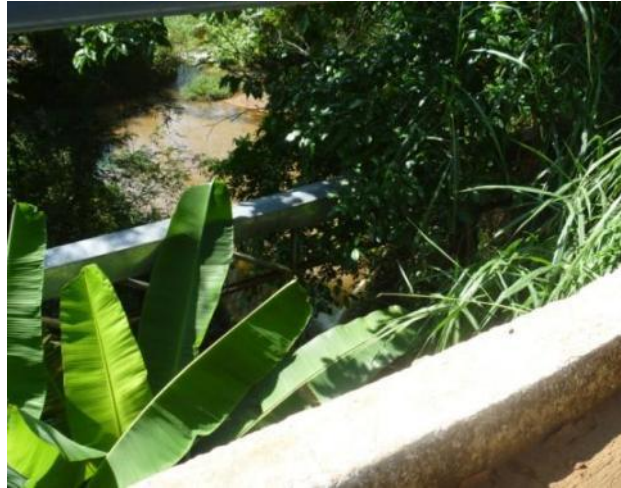
Figura 1.2 - Lançamento do esgoto in natura da sede no córrego Onça Grande
