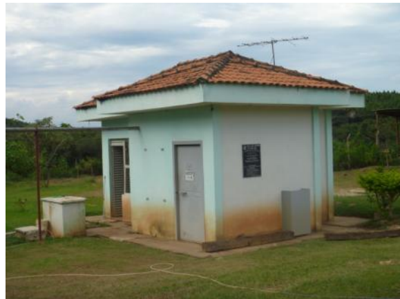
Figura 1.12 – Casa de apoio da ETE
