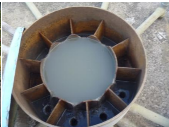
Figura 1.38 – Distribuição do esgoto no reator
