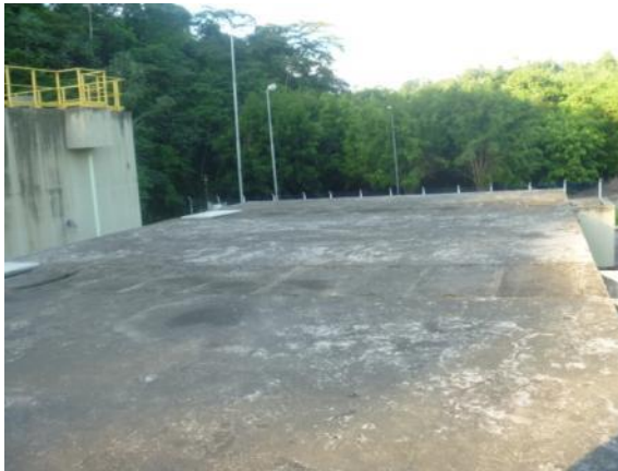
Figura 1.28 – Vista superior do filtro anaeróbio
