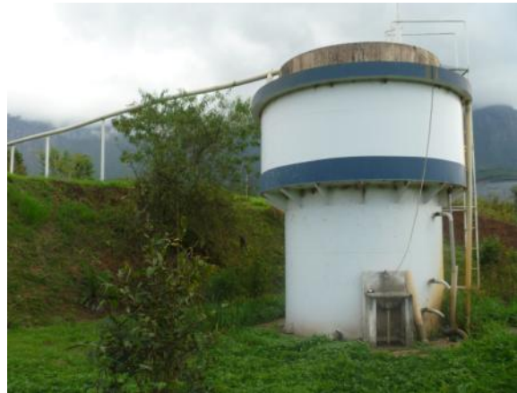
Figura 1.30 – Sistema Híbrido UASB/Filtro
