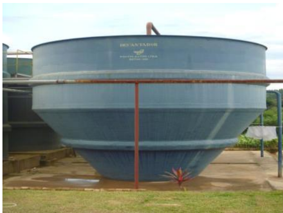
Figura 1.13 – Decantador
