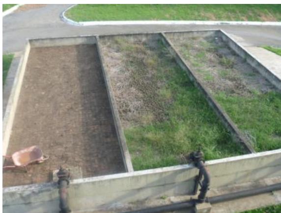
Figura 1.17 – Leitos de secagem
