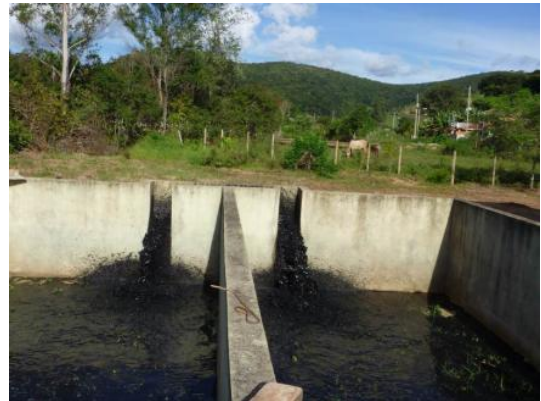
Figura 1.11 – Leitos de secagem de lodo
