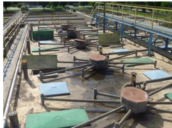
Figura 1.9 – Sistema de distribuição dos reatores UASB
