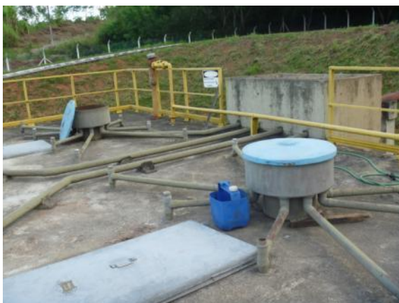
Figura 1.37 – Sistema de distribuição do reator
