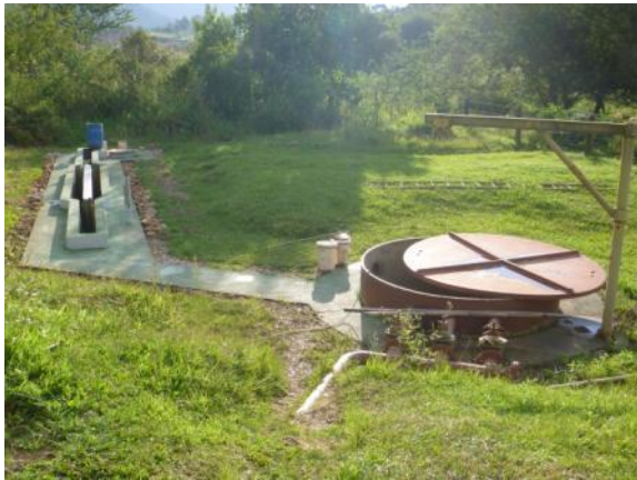
Figura 1.21 – Tratamento Preliminar e Bombeamento
