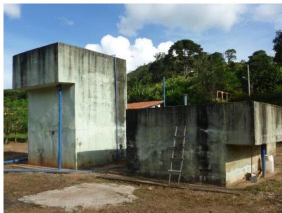
Figura 1.7 – Reator UASB e filtro anaeróbio
