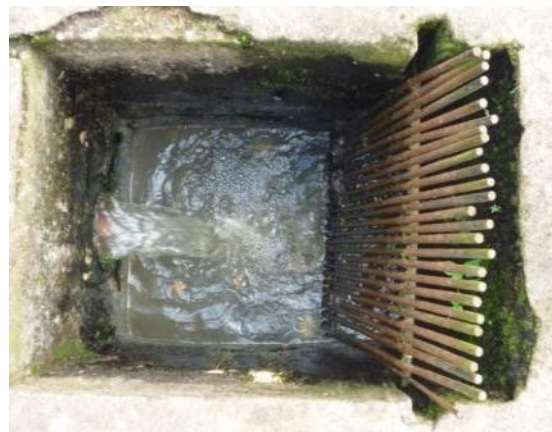
Figura 1.36 – Gradeamento
