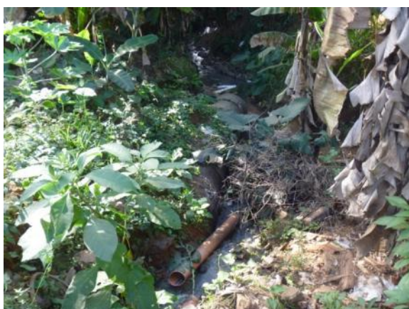
Figura 1.5 – Lançamento no córrego Basílio, no bairro São Bernardo
