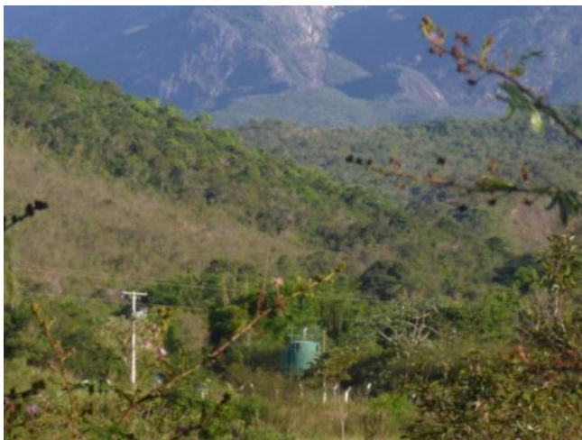
Figura 1.13 – ETE Sumidouro em obras. Ainda não há via de acesso livre
