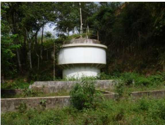
Figura 1.16 – Sistema Híbrido UASB/Filtro e Leitos de Secagem
