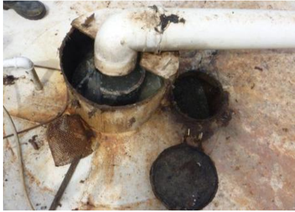
Figura 1.28 – Entrada do efluente no UASB
